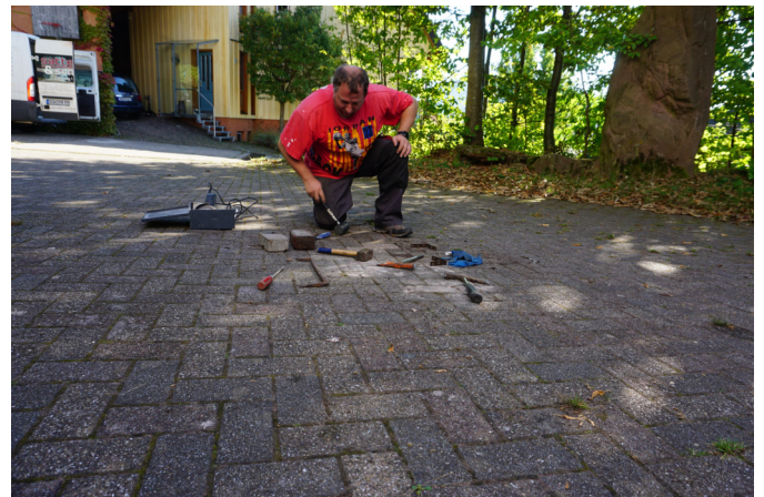
und der Polier, der nur noch den Stein einfügen muss
