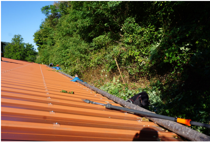
der Hang hinter der Halle wird gesäubert
