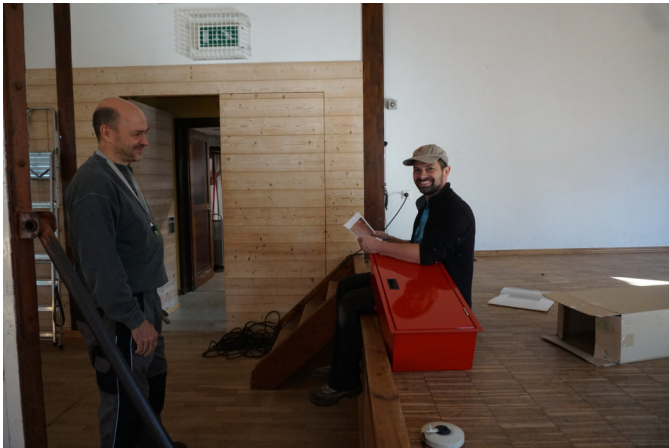
Vorbereitungen für den Feuerlöscher-Kasten
